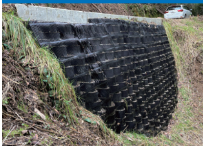
施主：氷見市役所 工事名：R4年豪雨災害 林道大平線(1号箇所)復旧工事
