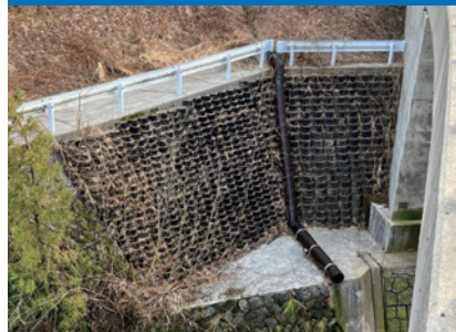
施主：石川県県央土木総合事務所 工事名：一般国道304号道路改築工事 (清水谷橋橋台部)
