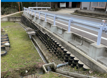
施主：氷見市役所 工事名：R2～3年 市道棚懸坪池道路改良工事
