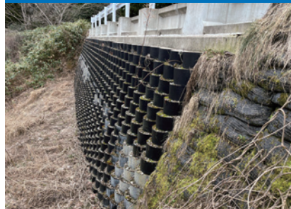
施主：氷見市役所 工事名：R2年度 林道幸原線改良工事
