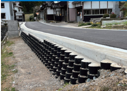
施主：氷見市役所 工事名：市道論田大谷線道路改良工事
