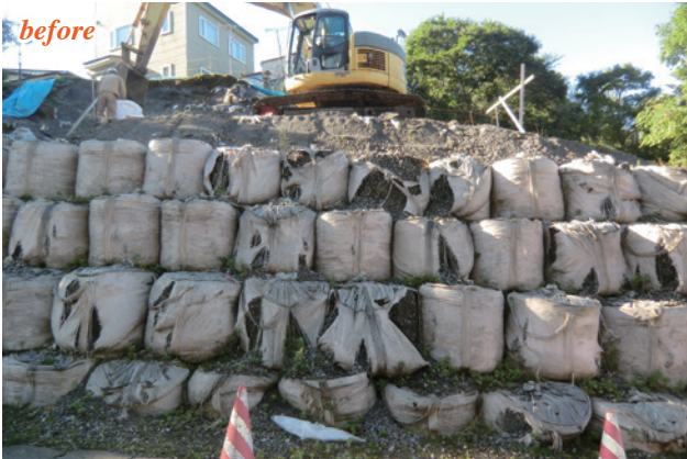
施主：民間 / 工事名：室蘭大沢地区民間擁壁工事 ■ 壁面勾配：(上段) 1:1.0 (下段) 1:0.5 ■ 壁高：(上段) 5.4m (下段) 6.9m ■ 壁面積：200㎡
