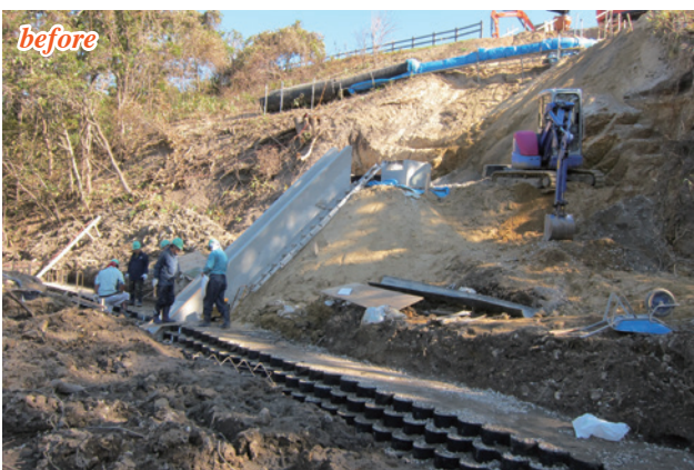
施主：青森県五所川原市役所 工事名：金木運動公園法面復旧工事 ■ 壁面勾配：1:1.0 ■ 壁高：5.0m ■ 壁面積：100㎡
