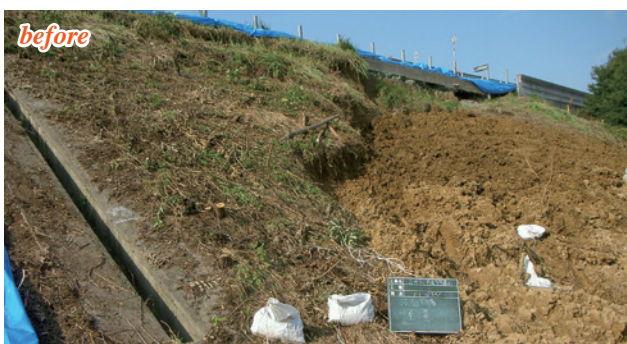
施主：都市再生機構千葉地域支社 / 工事名：千葉北部地区法面復旧工事 ■のり面勾配：1：1.5 ■型式：T-100MP ■のり面積：220㎡
