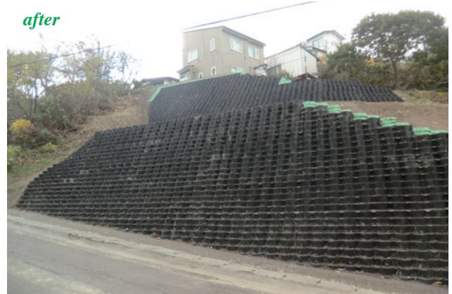
施主：民間 / 工事名：室蘭大沢地区民間擁壁工事 ■ 壁面勾配：(上段) 1:1.0 (下段) 1:0.5 ■ 壁高：(上段) 5.4m (下段) 6.9m ■ 壁面積：200㎡
