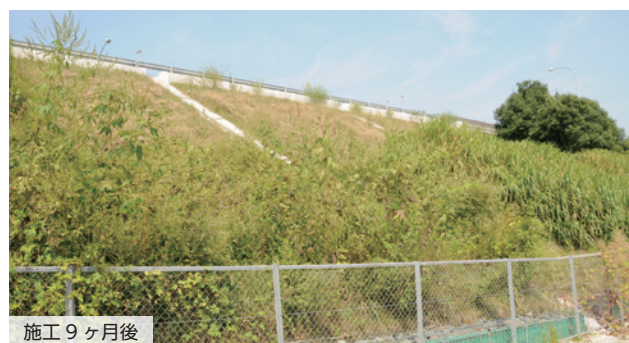
施主：東日本道路株式会社関東支社高崎管理事務所 / 工事名：上信越自動車道高崎管内災害復旧工事 ■のり面勾配：1：0.8 ■型式：T-100LP ■のり面積：426㎡
