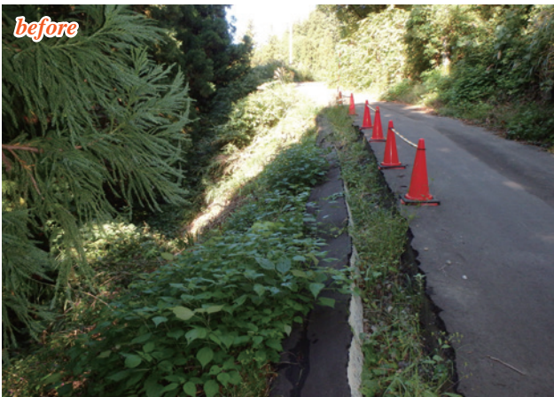
施主：新潟県十日町市役所 / 工事名：市道猿倉線道路災害復旧工事 ■ 壁面勾配：1：0.5 ■ 壁高：2.25m ■ 壁面積：40㎡
