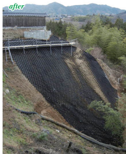
施主：長野県下条村役場 工事名：下条村コスモホール法面災害復旧工事 ■のり面勾配：1：0.8~1.2 ■型式：T-100MP ■のり面積：200㎡
