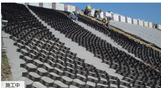
施主：東日本道路株式会社関東支社高崎管理事務所 / 工事名：上信越自動車道高崎管内災害復旧工事 ■のり面勾配：1：0.8 ■型式：T-100LP ■のり面積：426㎡
