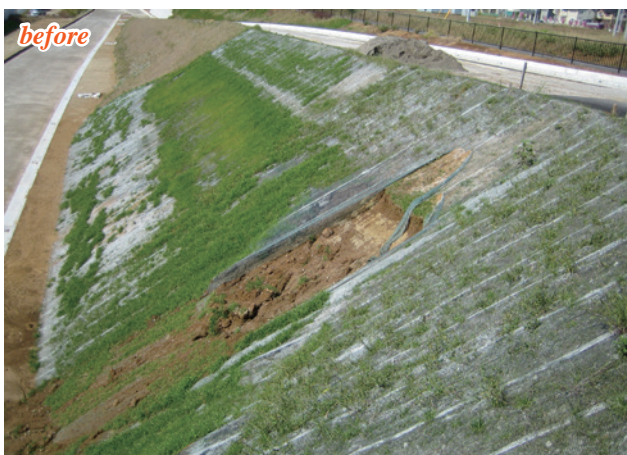
施主：都市再生機構千葉地域支社 / 工事名：千葉北部地区法面復旧工事 ■のり面勾配：1：1.5 ■型式：T-100MP ■のり面積：220㎡
