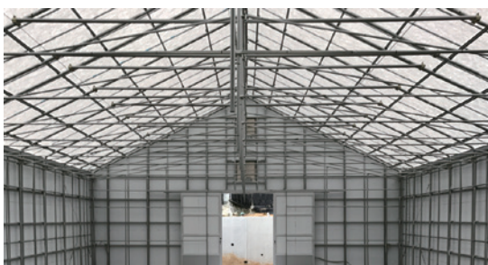
▲施工前 (外張り遮光 90%不織布)
