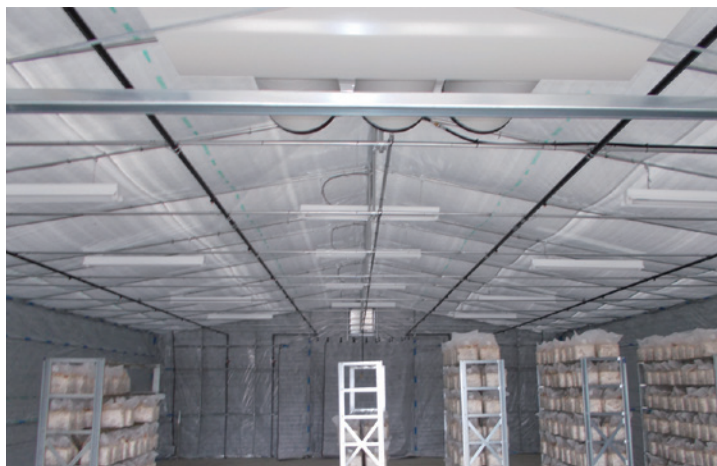
▲内張り施工後
