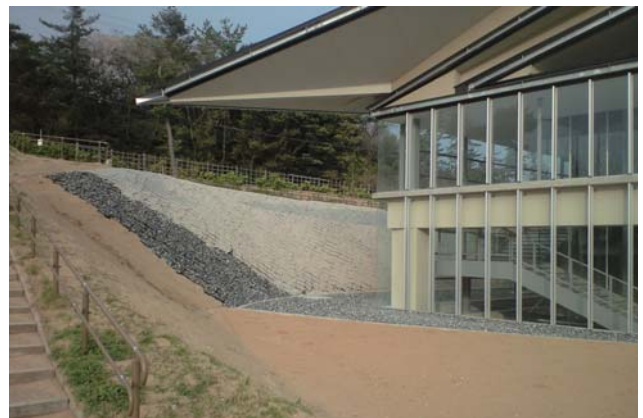
テラセルのり面保護工法
