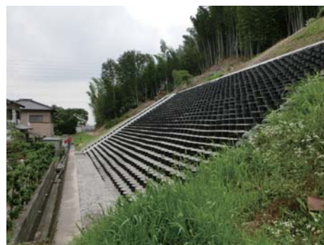
北大谷霊園災害復旧 (三重県)
