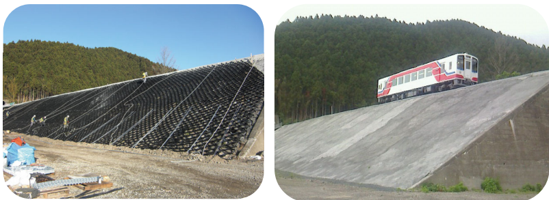
工事名：三陸鉄道南リアス線盛・吉浜間災害復旧工事
